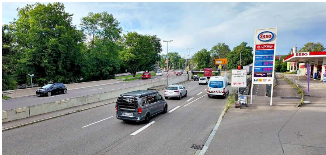
Der Hindenburgring in Ulm zwischen Westringtunnel und Blaubeurer Tor wird in den Sommerferien gesperrt. Ein Schild deutet bereits auf die Sperrung hin. FOTO: THOMAS HECKMANN
